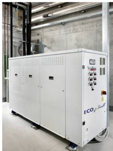
Co2-Verbundanlage (Foto: Epta)
