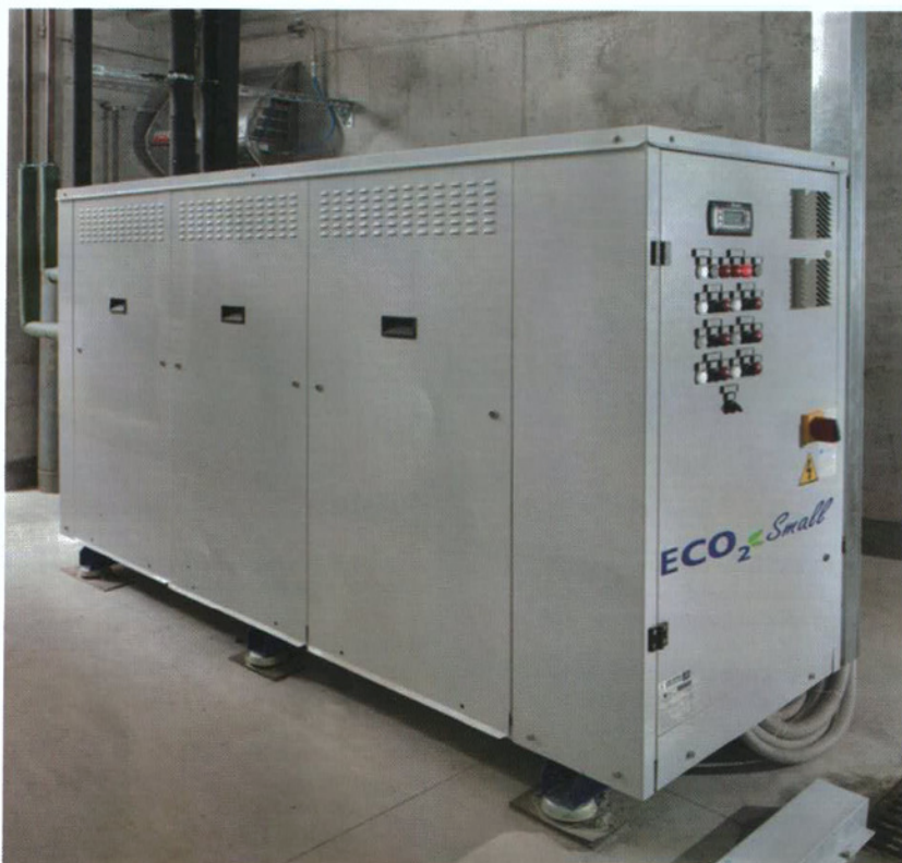
ECO 2 -small, la prima centrale interamente a CO 2 , transcritica per banchi a temperatura positiva e negativa studiata per piccoli e medi supermercati, hard discounts e stazioni di servizio. In termini di capacità frigorifera si arriva a 100 kW in MT e 20 kW in BT
