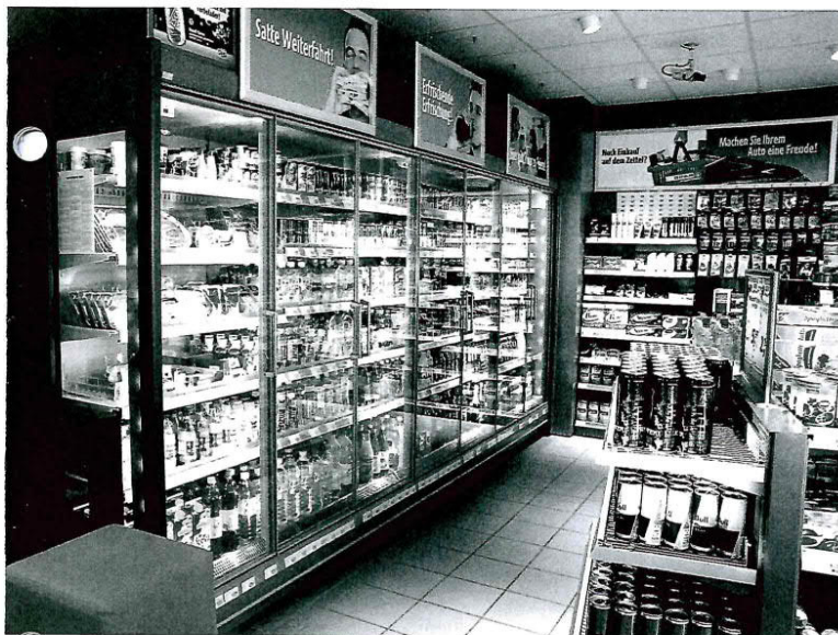
Geschlossenes Kühlregal von Hauser: Anders als bei offenen Kühlmöbeln enden die Etagen knapp hinter den Türen, so entsteht mehr Nutzfläche.
