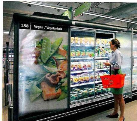
Bild 2: NK-Kühlmöbel mit Isolierglastüren
