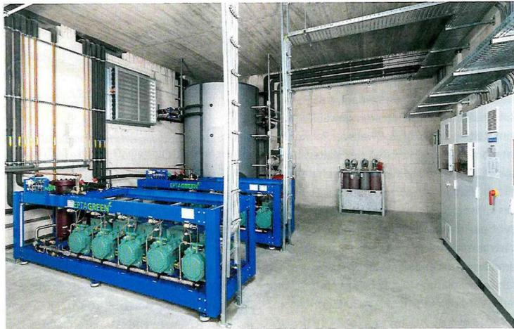
Die transkritische CO<sub>2</sub>-Kälteanlage versorgt die Lager- und Kommissionierräume sowie die Bananenreifeanlage mit Kälte.
