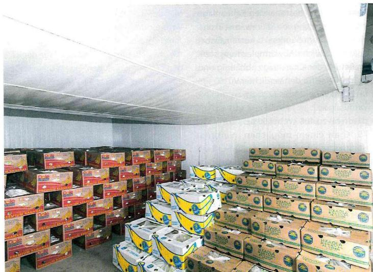
In den Kammern der Bananenreifeanlage herrscht eine konstante Temperatur von 14,5 °C.
