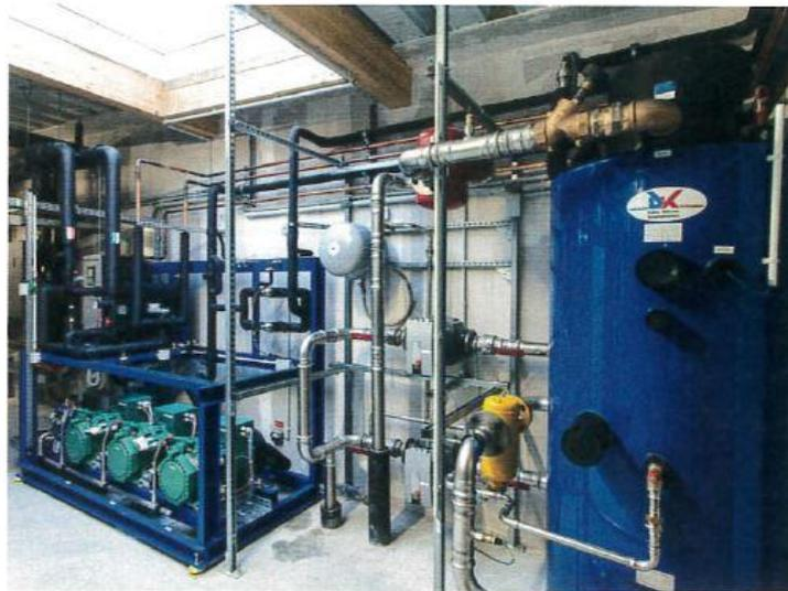
links: CO<sub>2</sub>-Wärmepumpe mit drei Verdichtern, einer davon ist invertiergegelt
