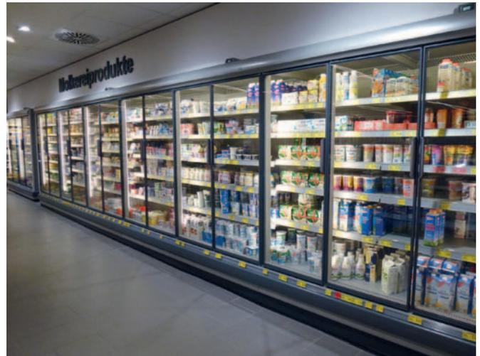
Die „Proxima“-Kühlregale von Epta wurden speziell für den Betrieb mit Glastüren konzipiert und erreichen die Eurovent-Energieklasse A.
