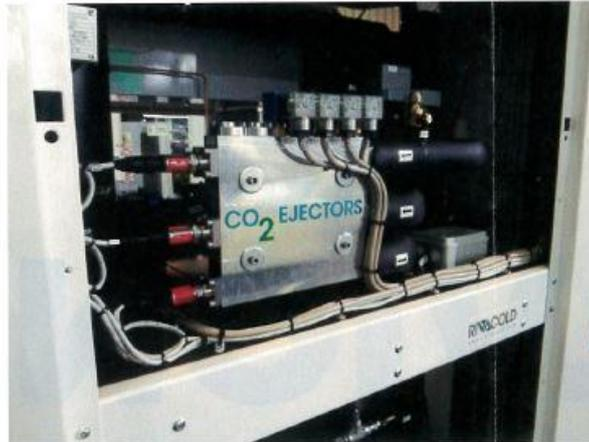
Ejektor für CO<sub>2</sub> mit bis zu sechs parallel angeordneten festen Düsendesigns – quasi ein digitaler Ejektor – wie er zum Beispiel von Danfoss angeboten wird.
