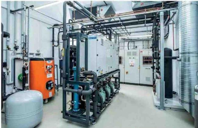
Viste le dimensioni del negozio si è deciso di adottare la centrale di ultima generazione **Eco2Middle** a CO<sub>2</sub> transcritico. Le dimensioni compatte e il design modulare ne facilitano il passaggio attraverso ingressi standard per il posizionamento in locali tecnici che potrebbero avere dimensioni ridotte.
