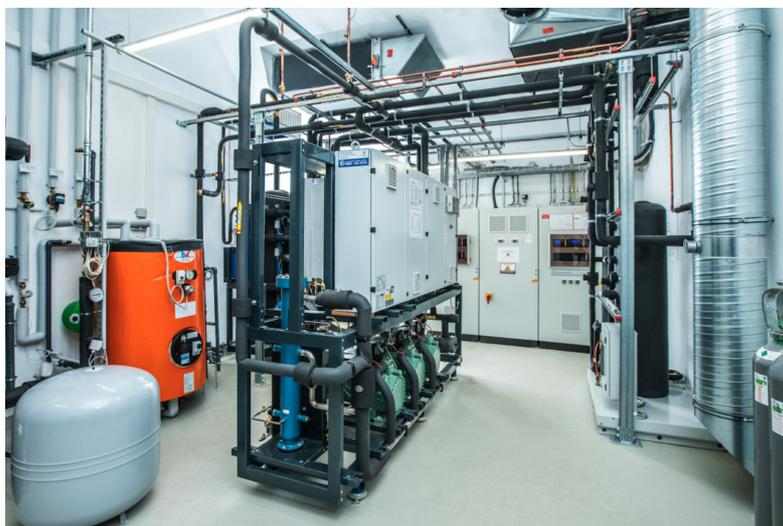
ottimale. Si tratta di una **centrale di ultima generazione aCO<sub>2</sub> transcritico**, ideale per i punti vendita di medie dimensioni, connotata da un **design modulare e compatto**: con una profondità di 80 cm e un'altezza di 200 cm, Eco<sub>2</sub>Middle può essere trasportata attraverso ingressi standard e installata in locali tecnici, anche di ridotte dimensioni.
