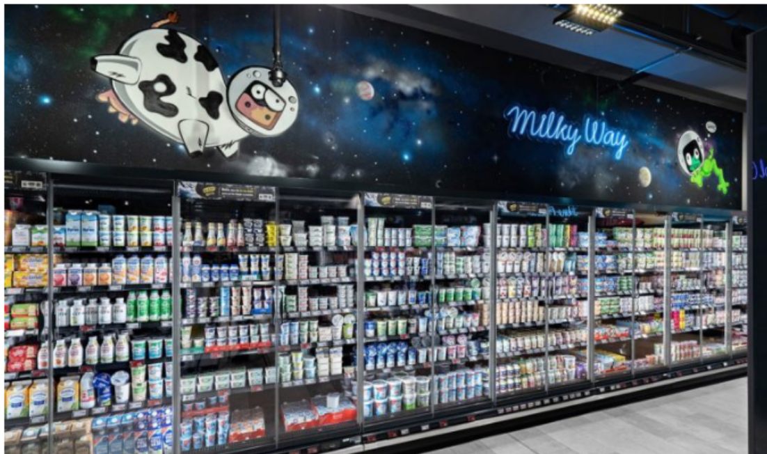
Im neuen Edeka-Markt Treugut in Berlin-Schöneberg hat Epta den Milky Way möbliert. Foto: Epta
