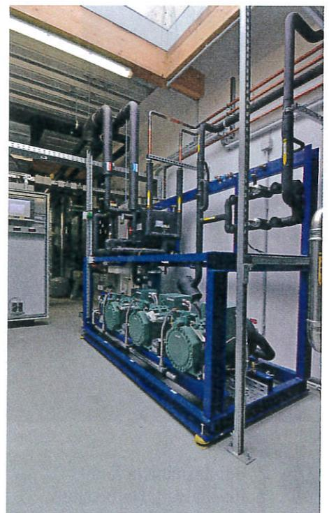
CO<sub>2</sub>-Verbundsatz der Firma Epta mit Wärmerückgewinnung im Technikraum
