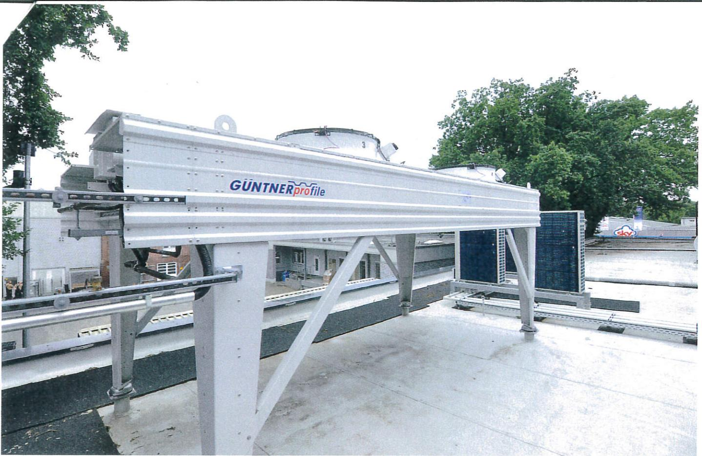
Im Gaskühler „Vario FLAT S-GVH“ kommen Kernrohre aus einer hochfesten Kupferlegierung mit kleinerem Rohrdurchmesser zum Einsatz. Dies führt zu einem reduzierten Rohrvolumen der Geräte.
