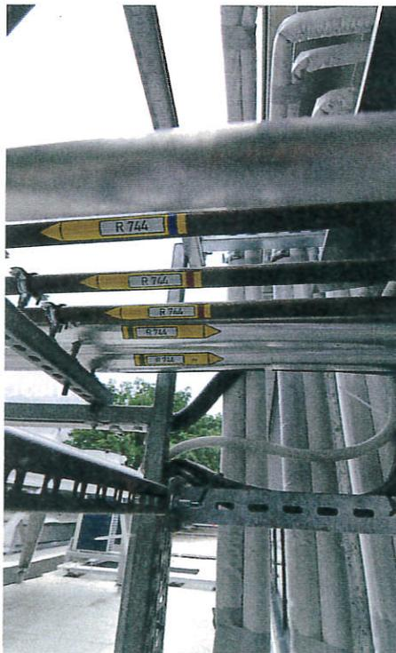
Der CO<sub>2</sub>-Kreislauf bewegt sich ausschließlich zwischen Technikraum und den außenaufgestellten Komponenten wie dem Gaskühler.
