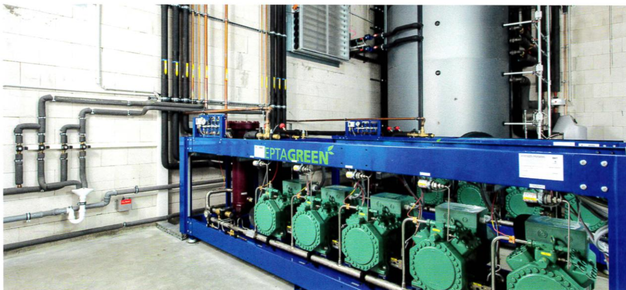
Beispiel einer transkritischen Kälteanlage als Alternative für von der F-Gase-Verordnung für das »Phase Out« vorgesehene Kältemittel.
