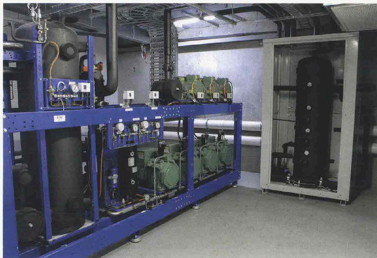
FTE Full Transcritical Efficiency, soluzione con cui EPTA apre la strada a un nuovo standard nell'ambito della refrigerazione naturale a CO 2
